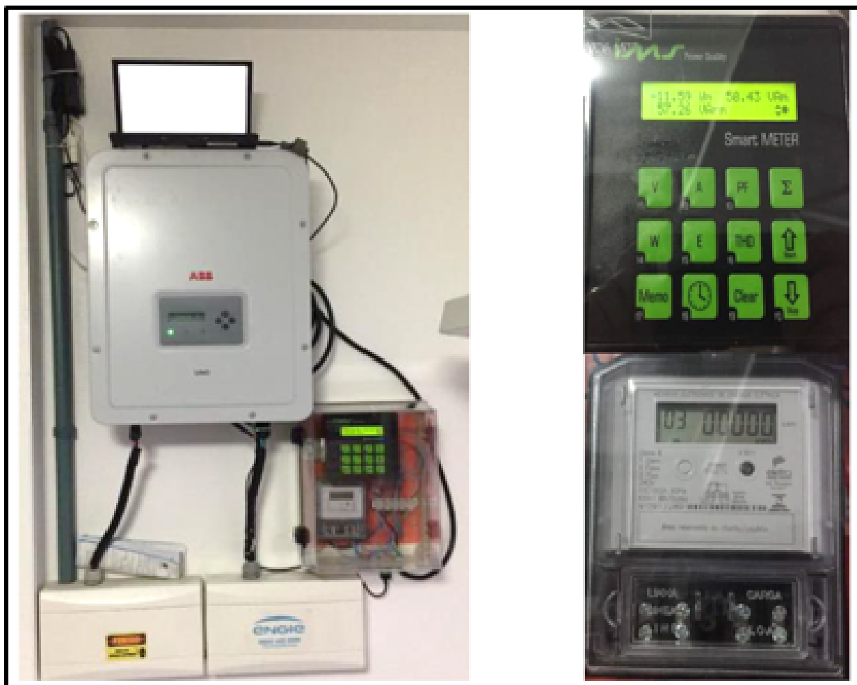
Figura 6 – inversor e medidor de energia, (os autores, 2024).
